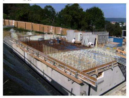
Armature avec des propriétés particulières: l'armature en fibre de verre ComBAR de Schöck ne peut pas être magnétisée, ne conduit pas l'électricité, résiste à la corrosion et est beaucoup plus légere que le béton armé.
