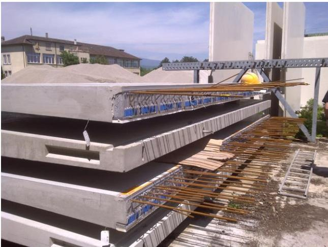
Für die rundum laufenden Balkone wurde der Isokorb bereits während der Vorfabrikation der Bodenplatten eingegossen.
