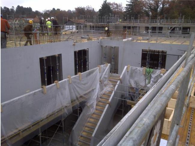
Die Bodenplatten der Laufgänge in den Innenhöfen wurden mit dem Schöck Isokorb® Typ K thermisch entkoppelt.
