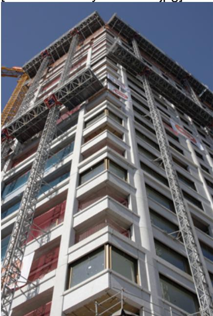
*Der Winddruck, der auf das Hochhaus einwirkt und mit der Gebäudehöhe zunimmt sowie die Auflasten der Fassadenelemente machten unter anderem die Isokorb-Sonderanfertigungen nötig.*
