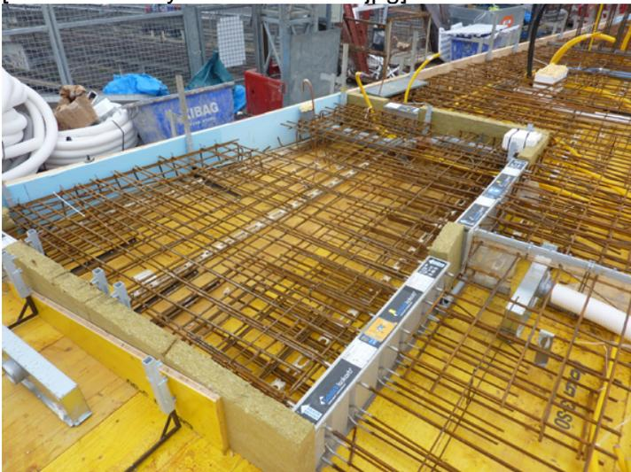
*Über 500 Isokorb-Elemente von Schöck in unterschiedlicher Ausführung kamen im Zölly Hochhaus für den Anschluss der eingezogenen Balkonkragplatten zum Einsatz.*
