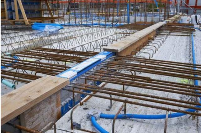
Die Schöck Isokorb Elemente wurden je nach Deckenstärke und Balkentiefe – sie reicht von 160 bis 220 cm – unterschiedlich dimensioniert und im Werk exakt nach Vorgabe produziert.
