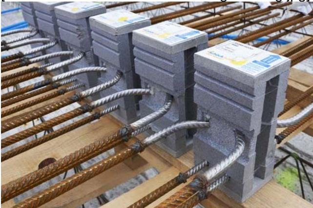
Mit dem tragenden Isokorb-Ergänzungsmodul Typ EQ, jeweils seitlich am Standard-Isokorb Typ K angebracht, werden im Erdbebenfall punktuell horizontale Querkräfte absorbiert.
