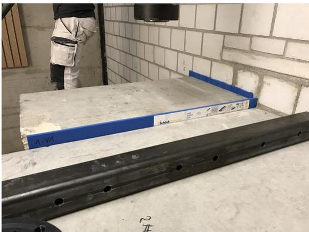
Abbildung 5: Tronsole® in eingebautem Zustand.
